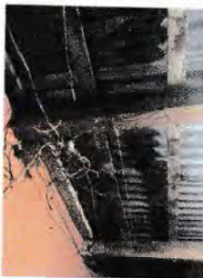
Foto 5: tendido electrico en mal estado, sustitucion de cables por nuevos
