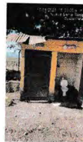
Foto 6: sustitucion de estructura de madera por estructura de metal, sustitucion de lamina por lamina troquelada
