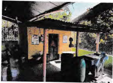
Foto 1: Sustrucion de Lamina, por lamina troquelada
